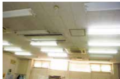
LED照明に切替(常時使用室)
