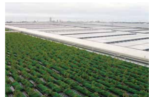
Co 2 削減が期待される「屋上緑化と太陽光発電施設の併設」
